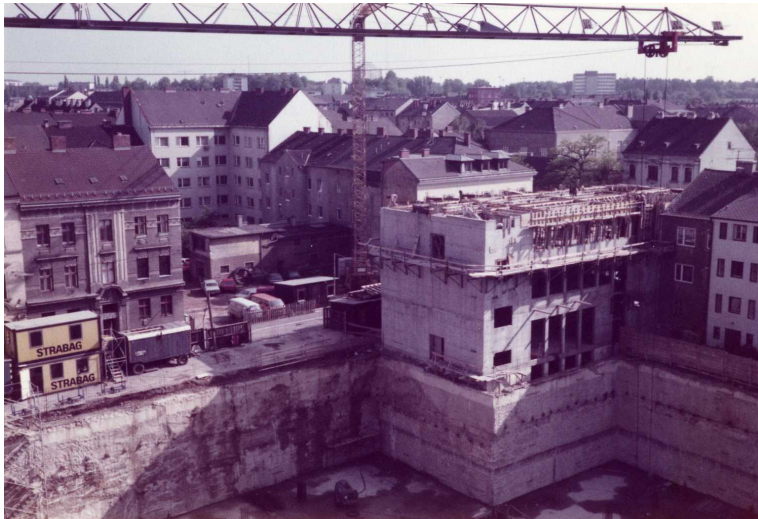
BFI_70er Jahre, Raimundstraße Baugrube
